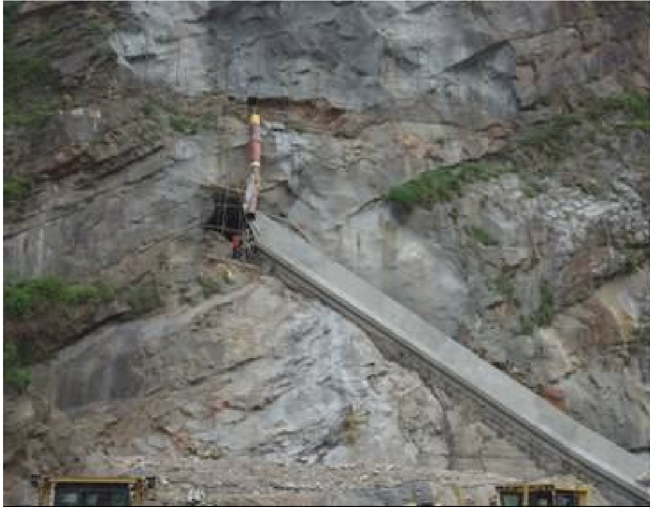
Final pouring – Section 16
