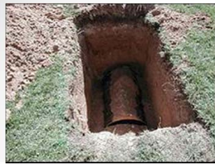
UNLV EGT site
