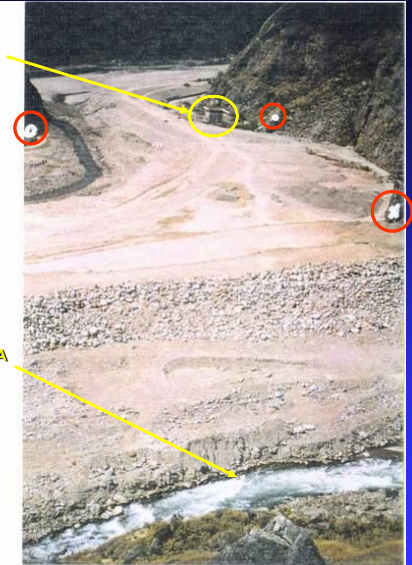
VISTA PANORAMICA DE LA CENTRAL (DESPUES DEL SINIESTRO - AGOSTO DE 1999)
