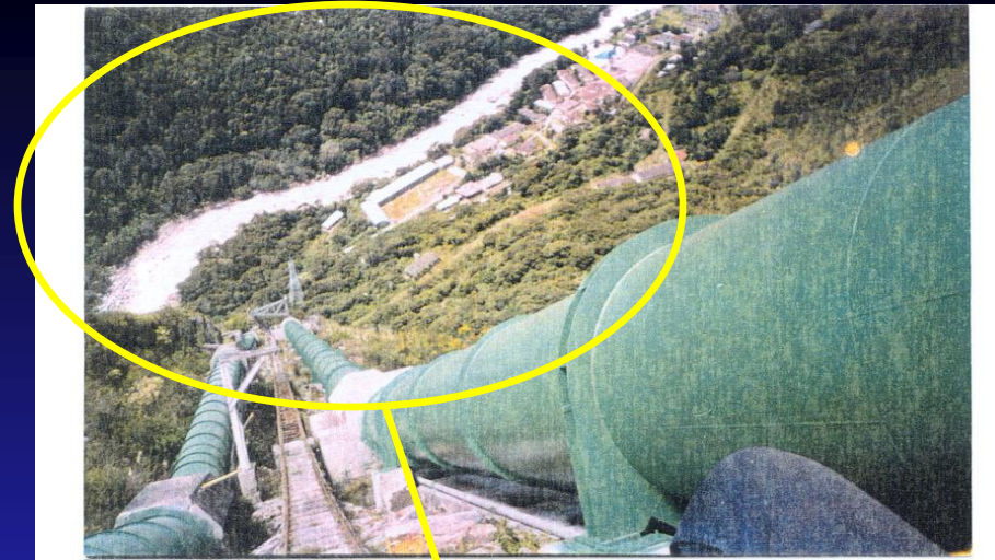
VISTA PANORAMICA TUBERIAS DE PRESION (15 DE ENERO DE 1998)
