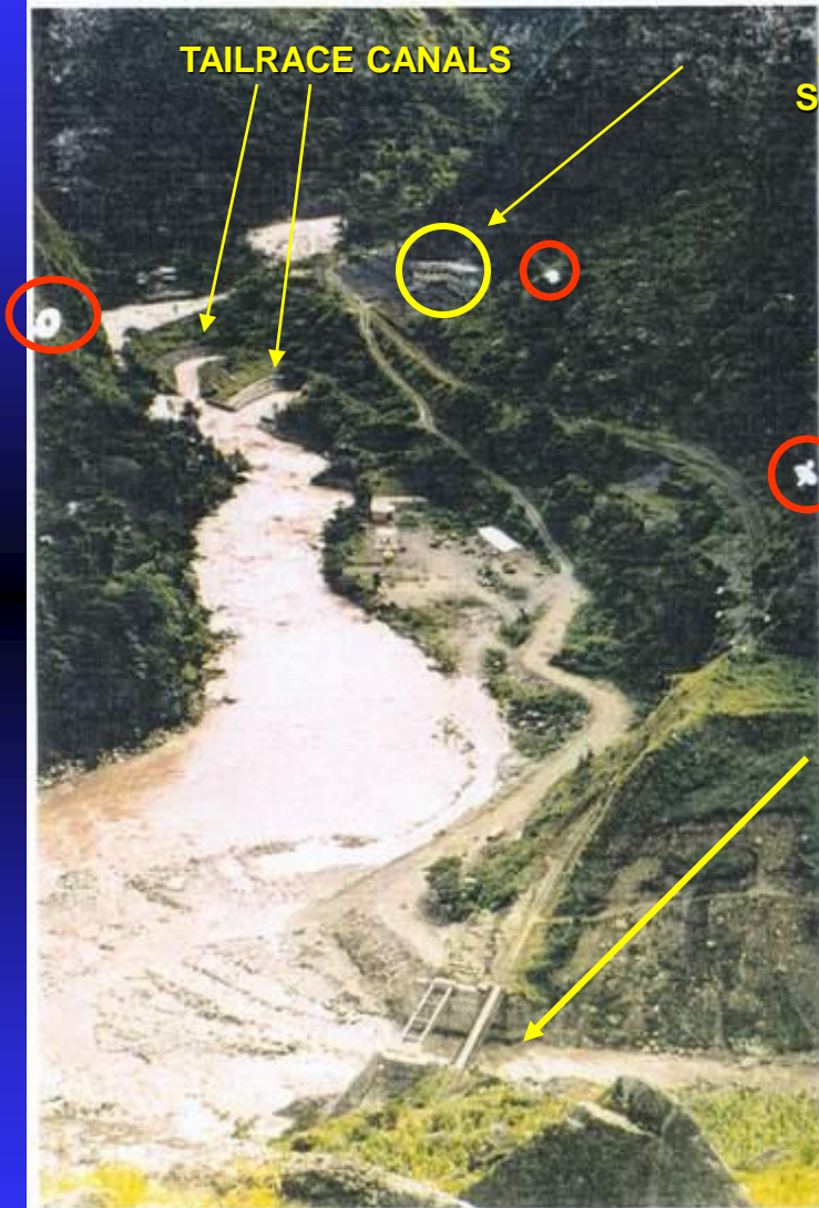
VISTA PANORAMICA DE LA CENTRAL (ANTES DEL SINIESTRO - ENERO 1998)
